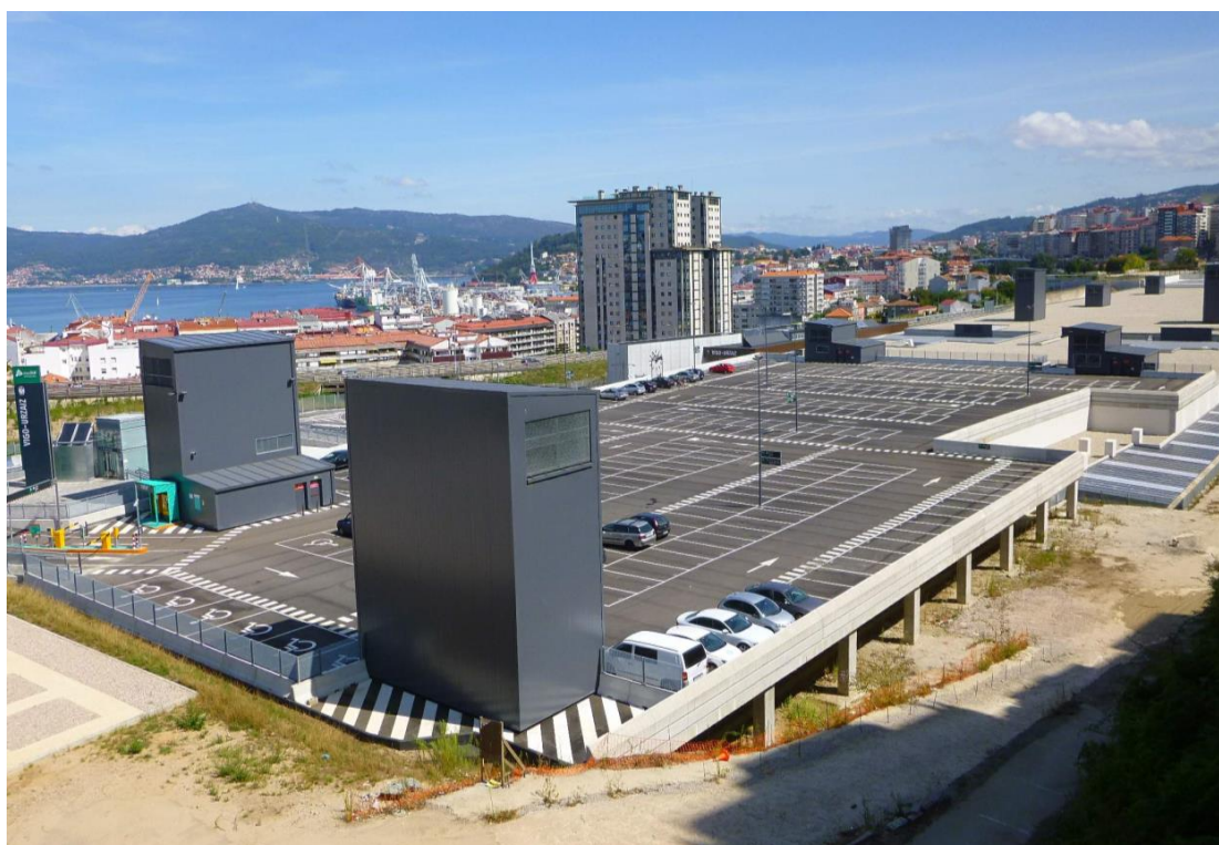
Figura 5. Zona de estacionamiento de vehículos sobre la nueva estación de ferrocarril Vigo-Urzáiz
