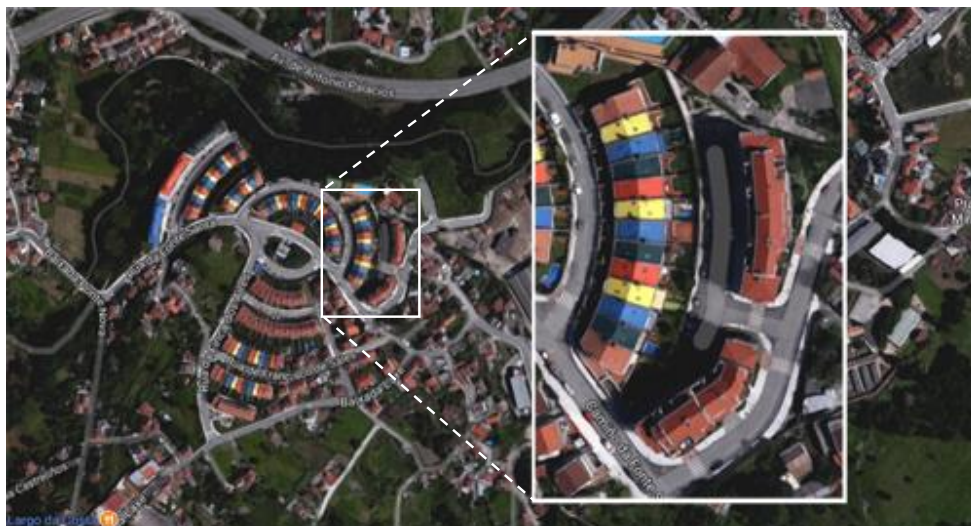
Figura 27. Localización de los edificios en Rúa Enrique A. Xalueiro
