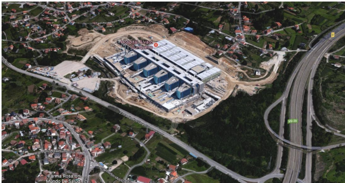
Figura 6. Vista panorámica del nuevo hospital Álvaro Cunqueiro
